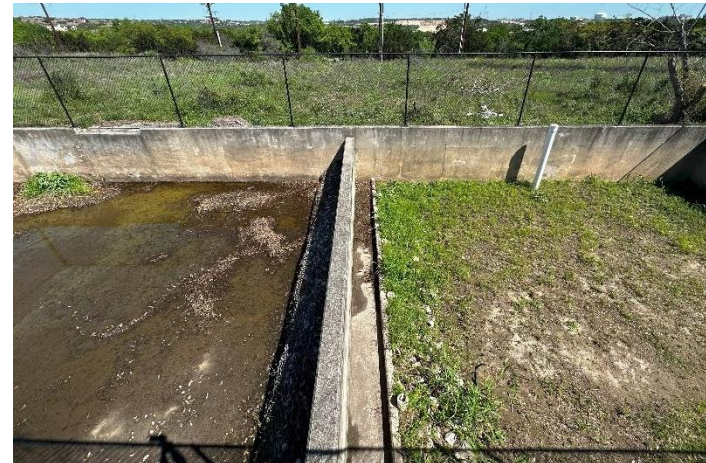
Figura 19: El agua estancada indica el mantenimiento necesario para una filtración adecuada, que incluiría la eliminación de sedimentos.
