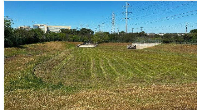
Figura 18: Sistema de filtración de arena debidamente mantenido; No hay agua estancada, plántulas de árboles o escombros. La altura del césped también es buena.
