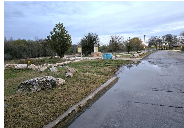
Figura 17: La eliminación del lodo es necesaria para permitir que las aguas pluviales entren en el área del césped.
