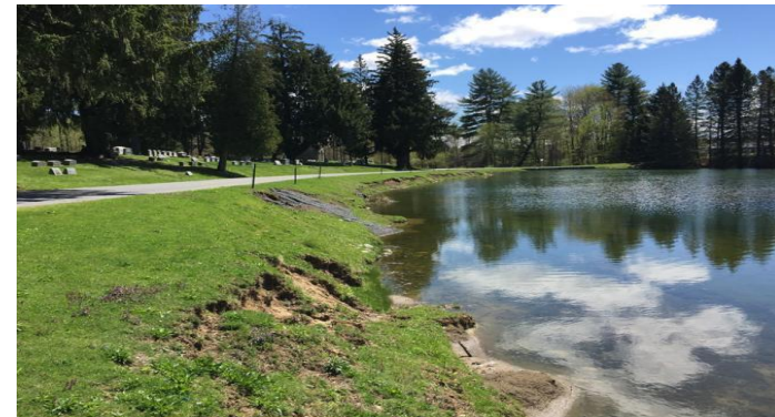
Figura 14: El corte hasta el borde provoca erosión, rotura de bancos y sedimentos llenando el lago.
