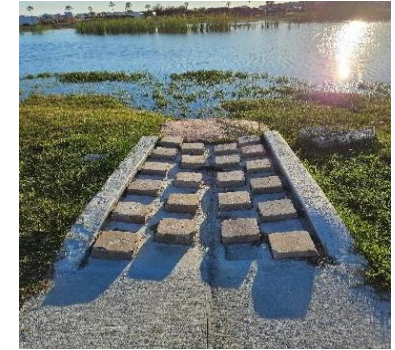
Figura 16: Esta característica dirige y ralentiza las aguas pluviales a la vez que previene la erosión.
