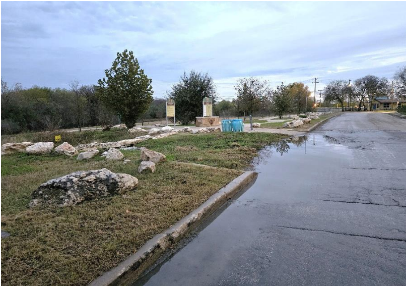
Figura 17: La eliminación del lodo es necesaria para permitir que las aguas pluviales entren en el área del césped.
