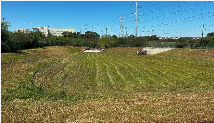
Figura 18: Sistema de filtración de arena debidamente mantenido; No hay agua estancada, plántulas de árboles o escombros. La altura del césped también es buena.
